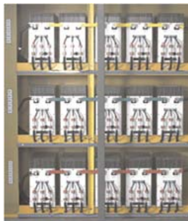
Секция силовых модулей
